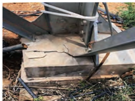
(c) #84号杆塔基础保护帽开落
